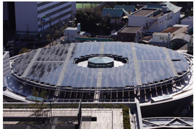
羽田クロノゲート内スポーツ施設屋上に太陽光パネルを設置
