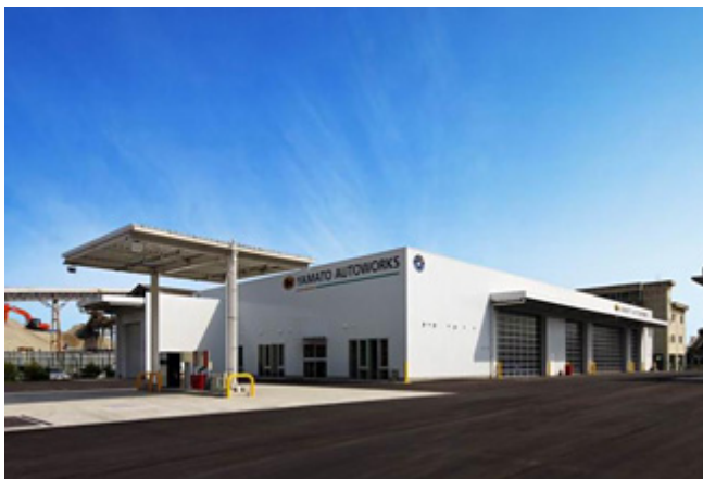
2013年4月に竣工した「スーパーワークス名古屋工場」
